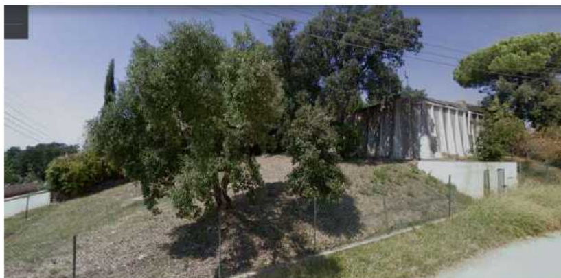
Vista dipòsits carrer Cánovas del Castillo. Font: Google Maps
